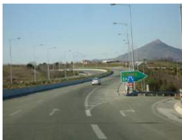
Εικόνα 91: Η διαγράμμιση στις λωρίδες όπου απαγορεύεται η είσοδος των οχημάτων και δύο τυπικά παραδείγματα.
