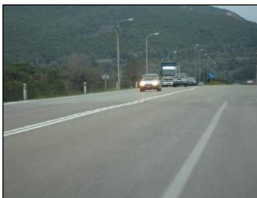
Εικόνα 86: Η μονή και διπλή οριζόντια διαγράμμιση των οδών (δεν επιτρέπεται προσπέραση) και παράδειγμα επί του Εθνικού οδικού δικτύου.
