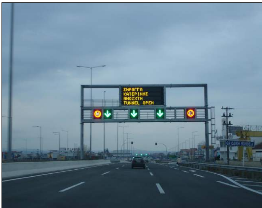
Εικόνα 95: Η ηλεκτρονική πινακίδα επάνω προειδοποιεί ότι η σήραγγα είναι ανοιχτή (VMS), ενώ οι ακραίες στρογγυλές πινακίδες (VDS) δείχνουν το όριο ταχύτητας, το οποίο μπορεί να μεταβάλλεται ανάλογα με τις συνθήκες.
