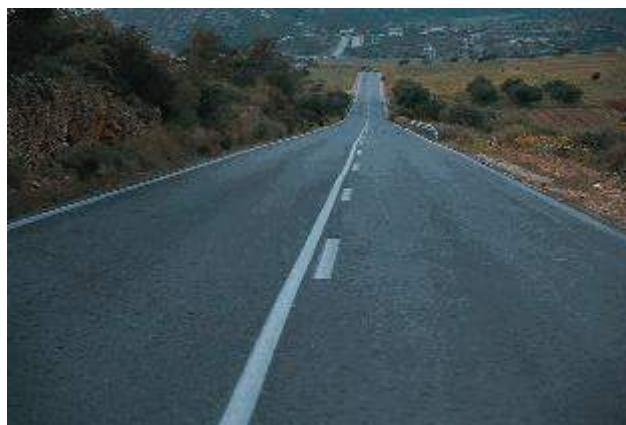
Εικόνα 88: Ο διαχωρισμός των λωρίδων και ένα παράδειγμα από επαρχιακή οδό της Θεσσαλονίκης.
