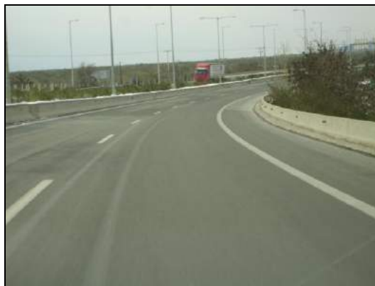
Εικόνα 87: Η διακεκομμένη οριζόντια διαγράμμιση των οδών και παράδειγμα επί του Εθνικού οδικού μας δικτύου.
