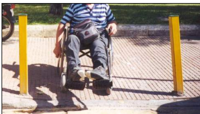
Εικόνα 16: Κατάλληλη κλήση πεζοδρομίου για άτομα με κινητικές αναπηρίες (Πηγή: Μπεκιάρης και συν., 2000).
