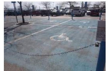
Εικόνα 7.10: Χώρος στάθμευσης για άτομα με αναπηρία
