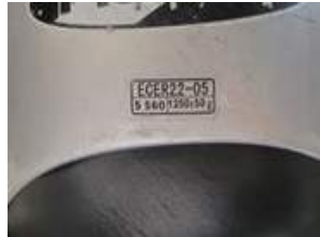
Εικόνα 1.8: Ένδειξη πιστοποίησης κράνου
