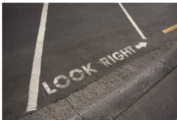
Εικόνα 7.26: Οριζόντια σήμανση σε χώρες που η οδήγηση γίνεται στα αριστερά
