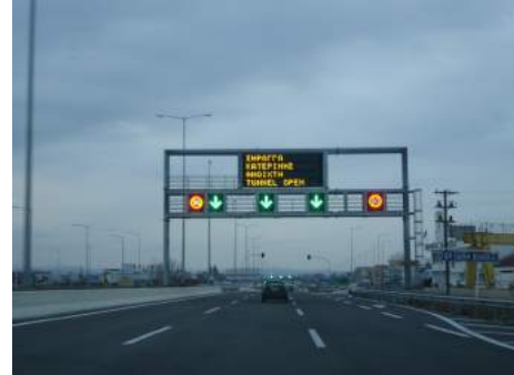
Εικόνα 4.19: Η ηλεκτρονική πινακίδα επάνω προειδοποιεί ότι η σήραγγα είναι ανοιχτή (VMS), ενώ οι ακραίες στρογγυλές πινακίδες (VDS) δείχνουν το όριο ταχύτητας, το οποίο μπορεί να μεταβάλλεται ανάλογα με τις συνθήκες.
