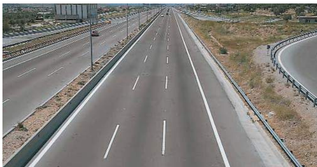
Σχ. 7.5α Αυτοκινητόδρομος.
